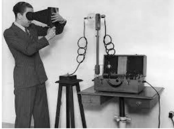
Fig. 3. Prototipo rayos X portátil
