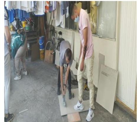
**Fig. 25: Corte de material con pulidora.**
